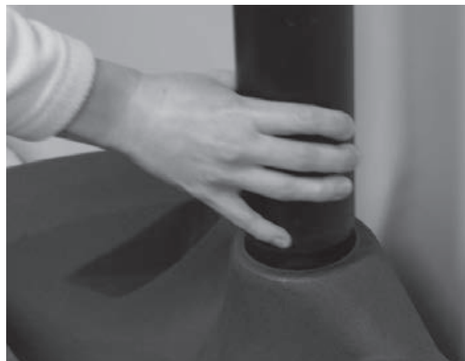
3. Abmontieren des Entlüftungsrohres
