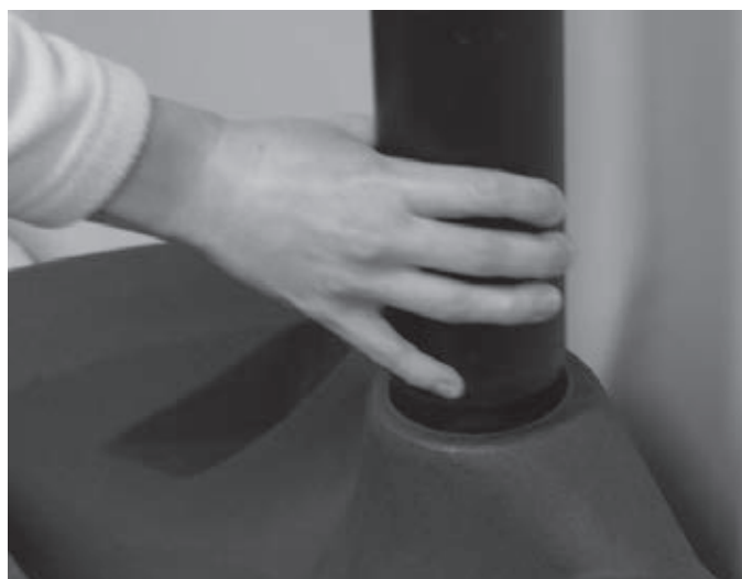
3. Desconexión de la tubería de ventilación
